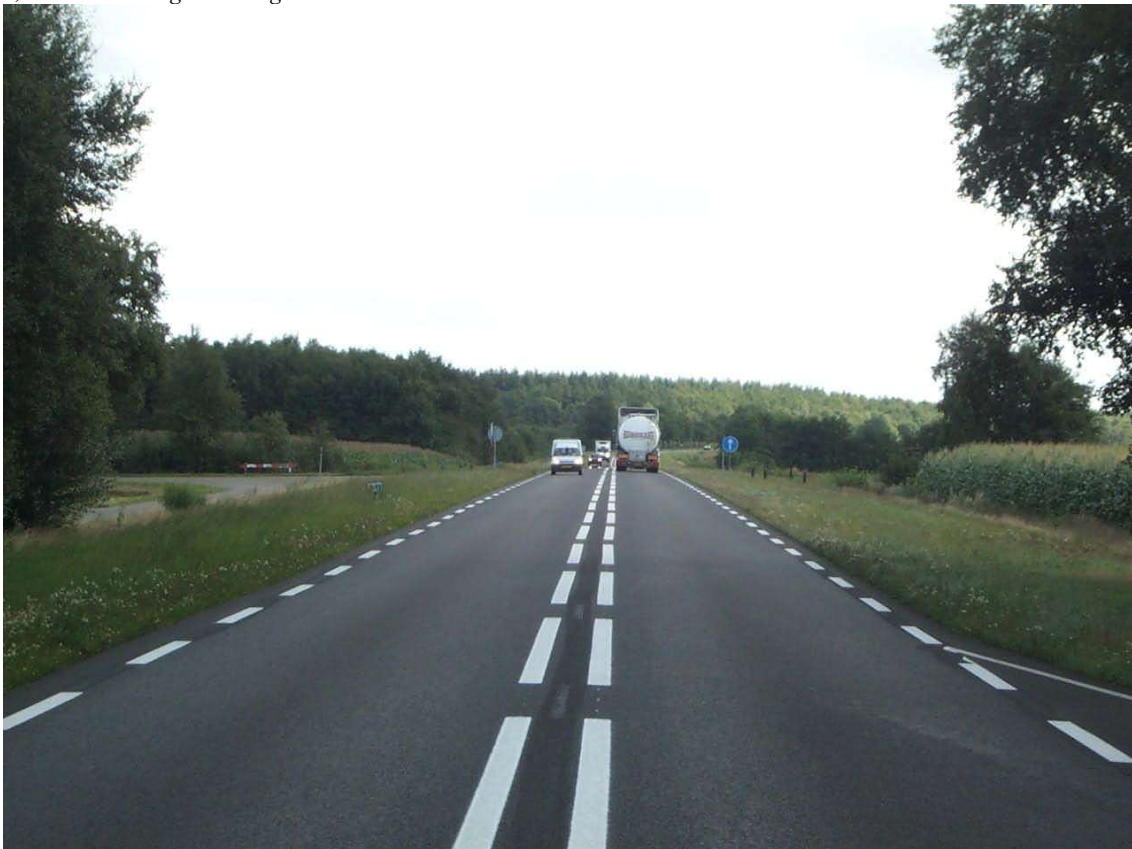
Figuur 2.2: Wegbelijning van het proefwegvak. Voor details wat betreft maatvoering, zie tabel 2.1. Foto: F. Cuperus (Provincie Drenthe), de foto is eerder gepubliceerd in LetOp!, de periodiek van het Regionaal Orgaan voor de Verkeersveiligheid in Drenthe (ROVD, 2001).
